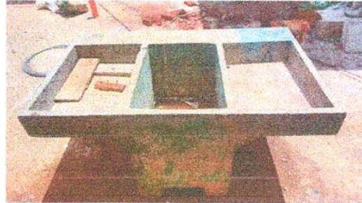
Foto 8: Sustitución de pila de cemento
