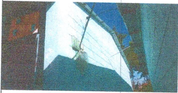
Foto1: Cambio de Pintura
