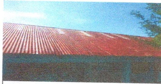
Foto 4: Sustitucion de Techo Aluzinc
